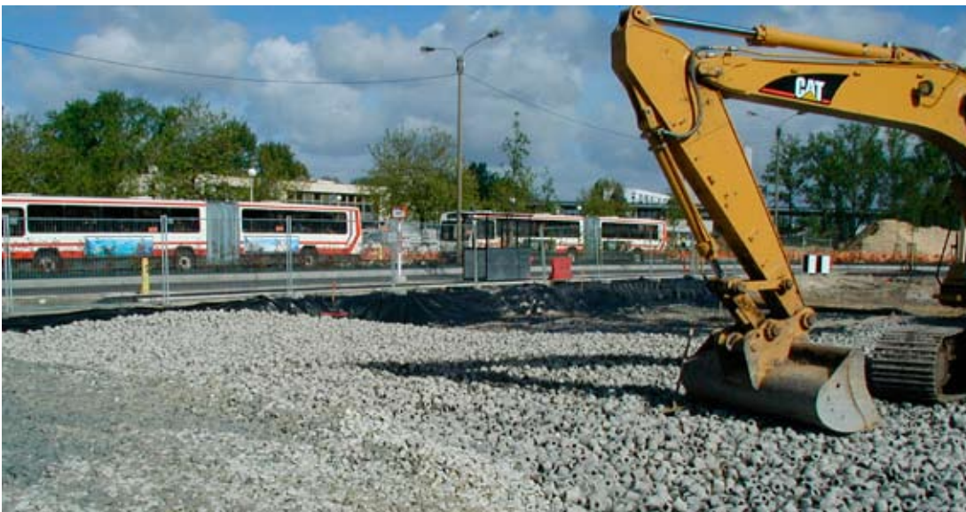
Scarti di calcestruzzo frantumati, possono essere utilizzati nella costruzione di strade. Per gentile concessione di: Photothèque CERIB.
