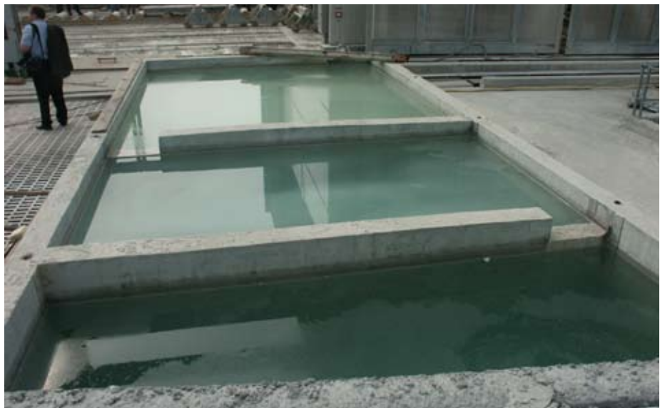
Nell'industria del calcestruzzo i materiali solidi contenuti nell'acqua di processo vengono estratti in modo tale che l'acqua possa essere riciclata per la produzione di calcestruzzo. Per gentile concessione di Precompressi Centro Nord, Verona.
